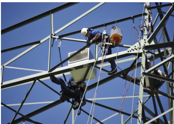
Abbildung 2-5: Montage eines Brutkastens
