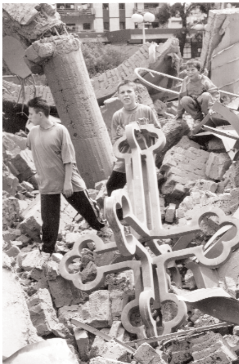
Albanska deca na Kosovu penju se po ruševinama Srpske pravoslavne crkve u Đakovici, koja je dignuta u vazduh jula 1999.
