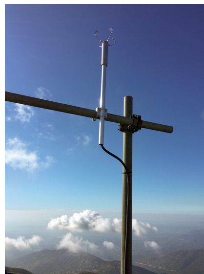
Figure 2. Anémomètre du mont Ventoux, au sommet du « géant de Provence ».
