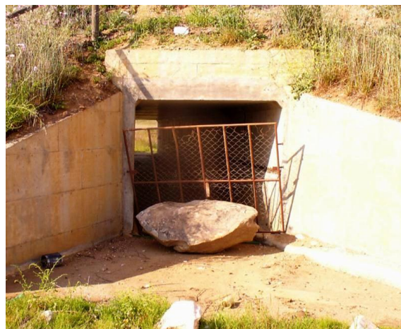
Fig. 22 – PH situada na EN256 junto do pk 32+200
