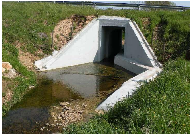
Fig. 19 – PH no IP2, próxima do pk 223, adaptada para fauna através da implementação de um passadiço.
