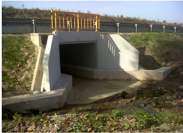
Fig. 22 – PH na EN18, ao pk 74,800, com dois passadiços secos
