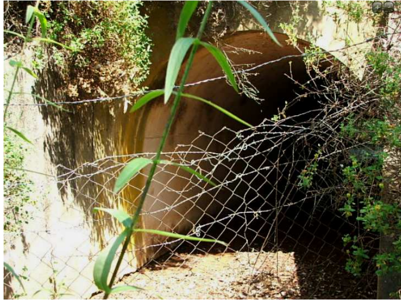
Fig. 18 – Passagem hidráulica nº 3832 junto ao ponto negro 4.
