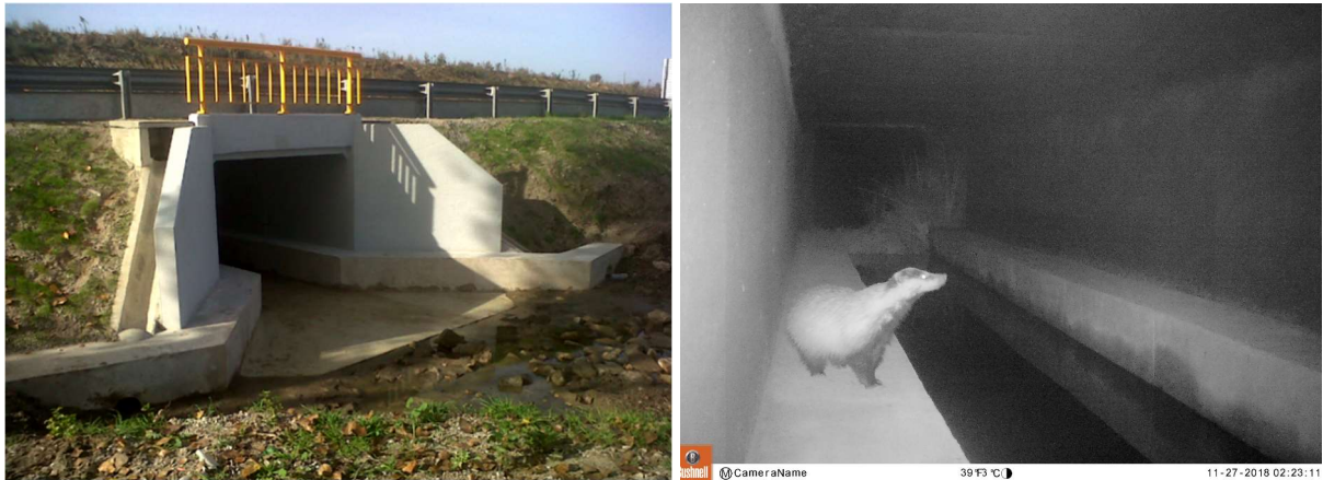
Fig. 34 – PH na EN18, ao km 274,800, com dois passadiços secos. Na fotografia da direita é possível visualizar um texugo a utilizar um dos passadiços (fotografia captada pela Universidade de Évora durante a monitorização da PH).
