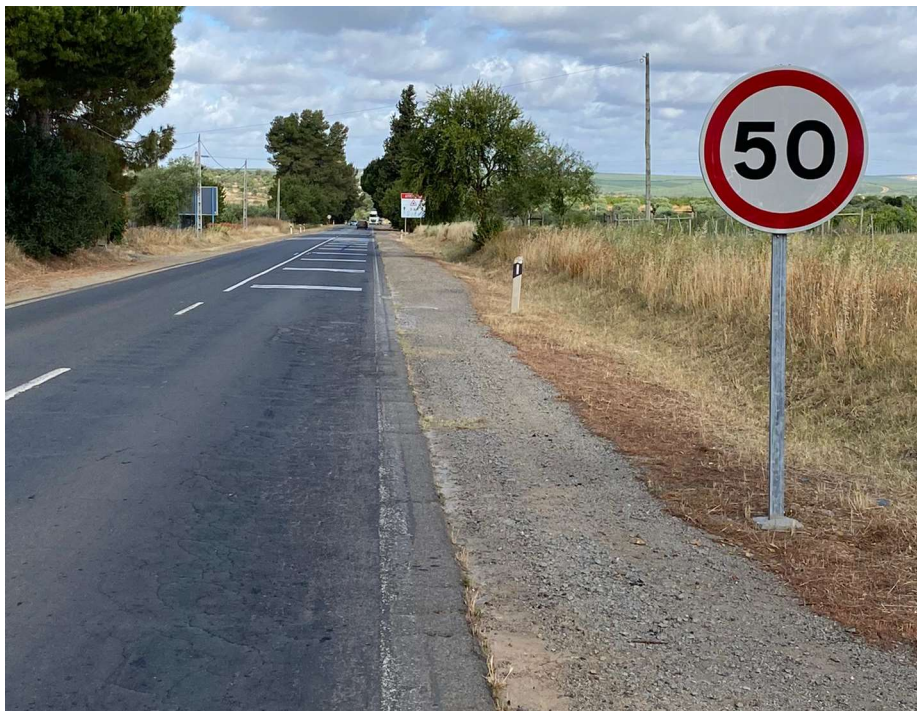
Fig. 30 – Sinalização de limite de velocidade na EN260, com bandas cromáticas e painel com sinalização de alerta relativa ao lince-ibérico (ao fundo).
