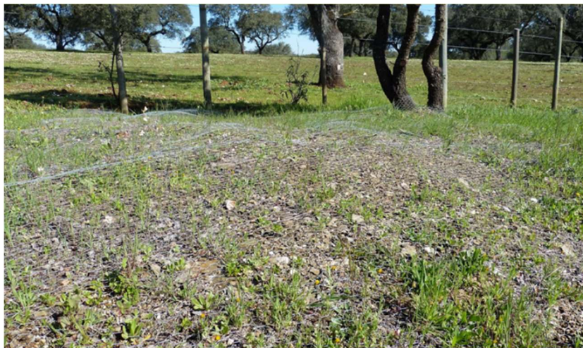
Fig. 32 – Colocação de rede sobre os taludes da EN4, com o objetivo de impedir a sua colonização por coelhos.
