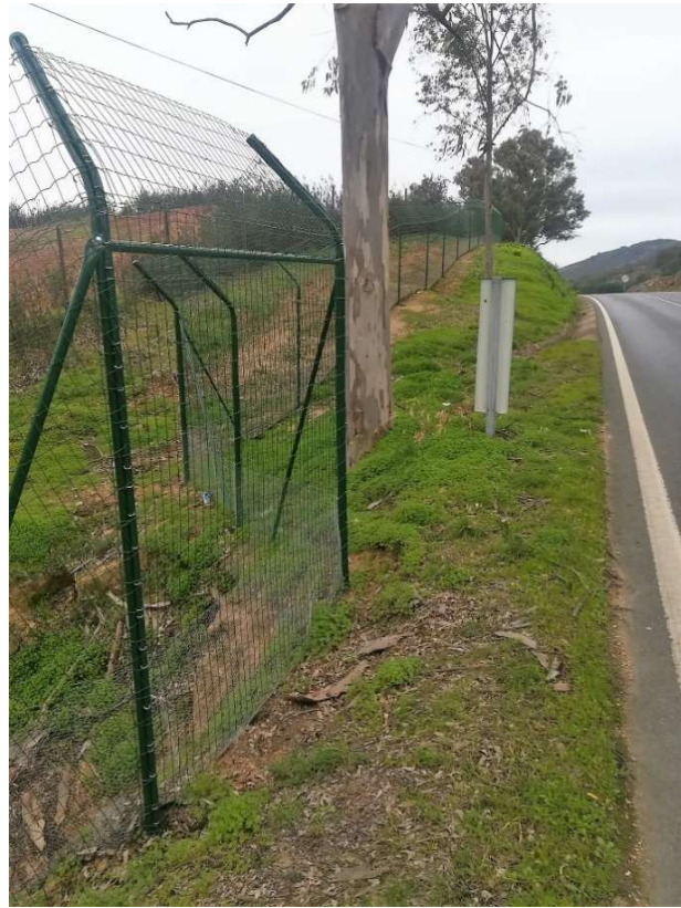
Fig. 29 – Vedação instalada na EN122.
