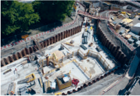
Bau des Fundaments für den Erweiterungsbau.
