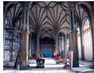
Bauarbeiten in der Ruhmeshalle vor dem Einbau der neuen Dauerausstellungen.
