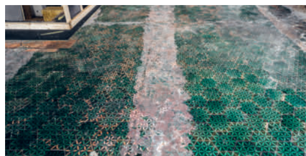
Mit der Aufdeckung, Restaurierung und Rekonstruktion der Bodenfliesen wurde der historische Westflügel wo immer möglich in den Zustand von 1898 zurückgeführt.
