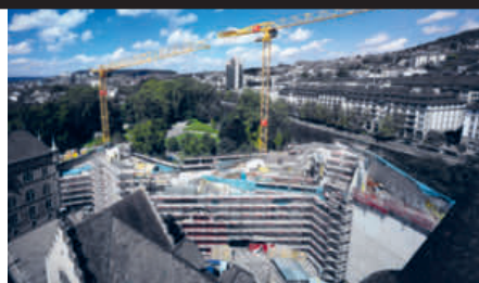
Fortschreitende Arbeiten am Erweiterungsbau.
