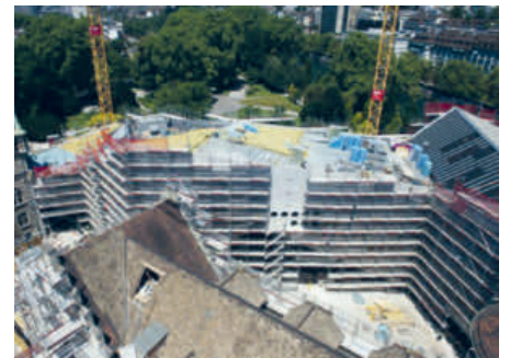
Der Erweiterungsbau nach dem Richtfest. Im Dezember konnte der Erweiterungsbau dem Museumsbetrieb übergeben werden.
