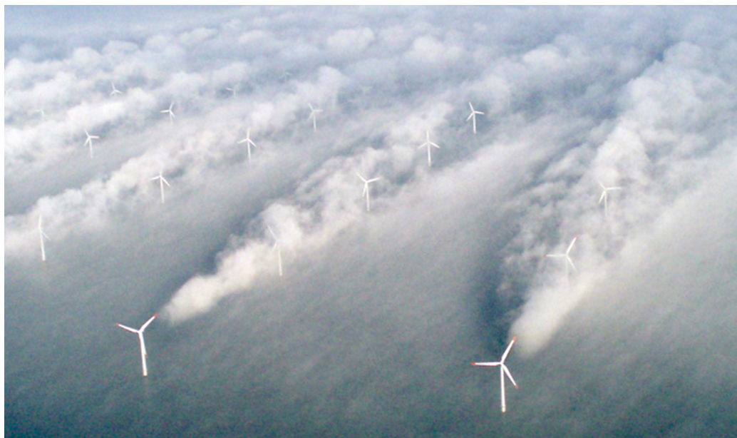
Fot. 3. Zawirowania powietrza tworzone za poruszającymi się turbinami wiatrowymi, źródło: ze zbiorów autora
