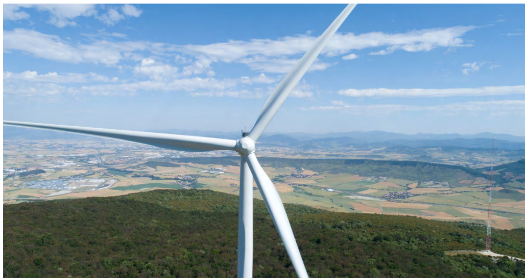
Fot. 4. Potężne łopaty turbin wiatrowych wpływają na efektywność działania radarów, źródło: ze zbiorów autora
