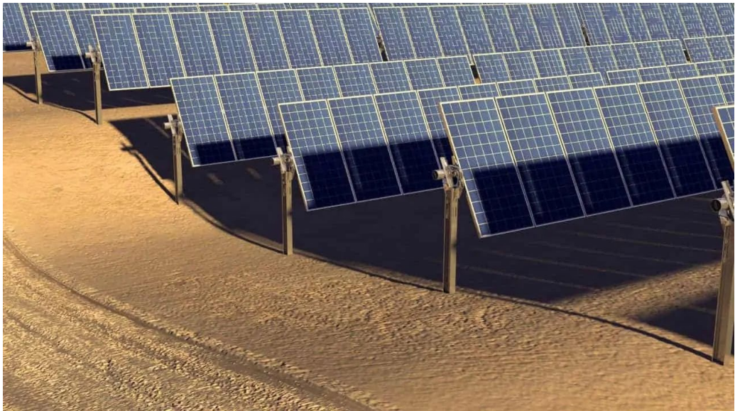
Fot. 5. Zacienienie paneli fotowoltaicznych to istotne zagadnienie przy projektowaniu systemów solarnych, źródło: systemy-fotowoltaika.pl
