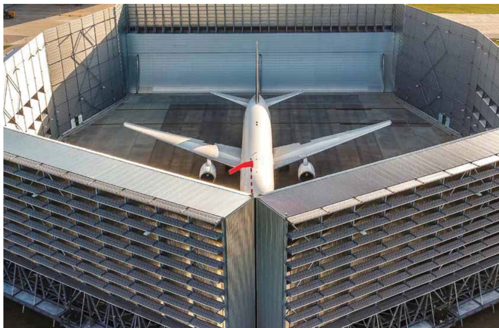
Fot.3. Ekrany akustyczne na stanowisku do testowania silników lotniczych, źródło: ze zbiorów autora
