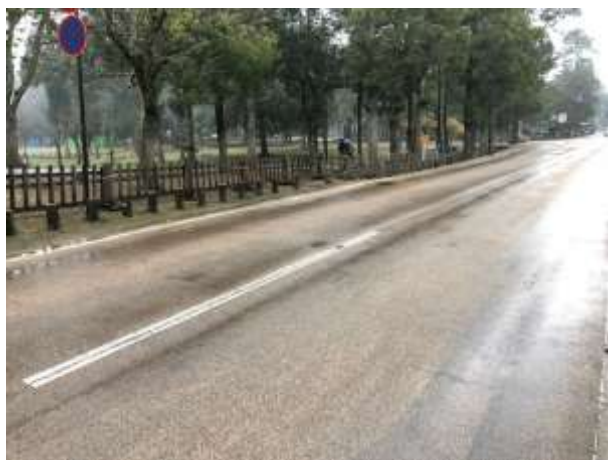
柵設置後の状況（遠景）
