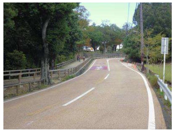
公園内道路のカラー舗装化
