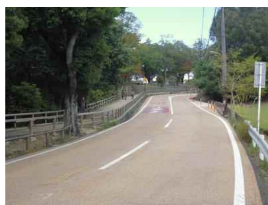
公園内道路のカラー舗装化
