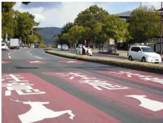
路面標示による注意喚起
