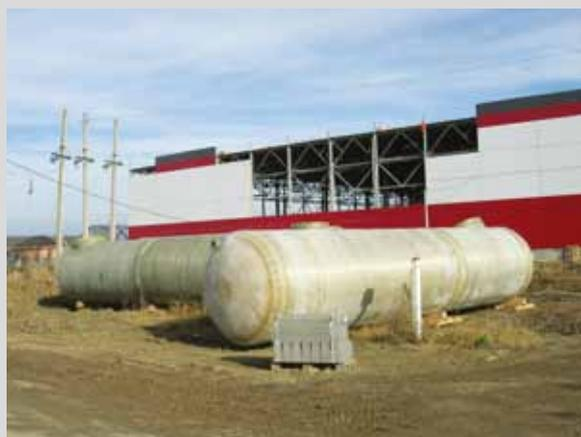
При очистке поверхностных сточных вод (ливнестоков) требуется направлять на очистные сооружения лишь первые 4-10 мм воды, содержащей осадок. Остальной поток условно чистых ливнестоков не нуждается в очистке и сбрасывается напрямую, минуя очистные сооружения.
