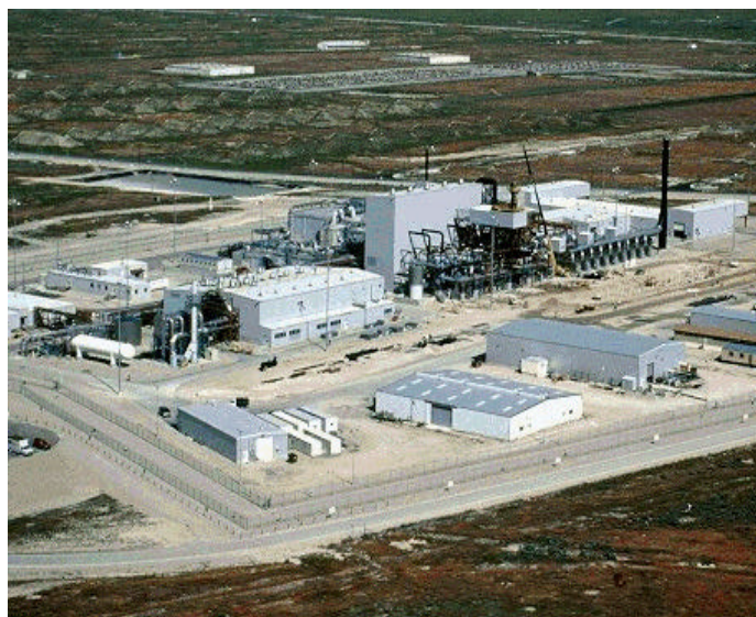
図. 1 Tooele の廃棄処理施設
