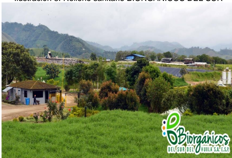
Ilustración 8. Relleno sanitario BIORGÁNICOS DEL SUR
