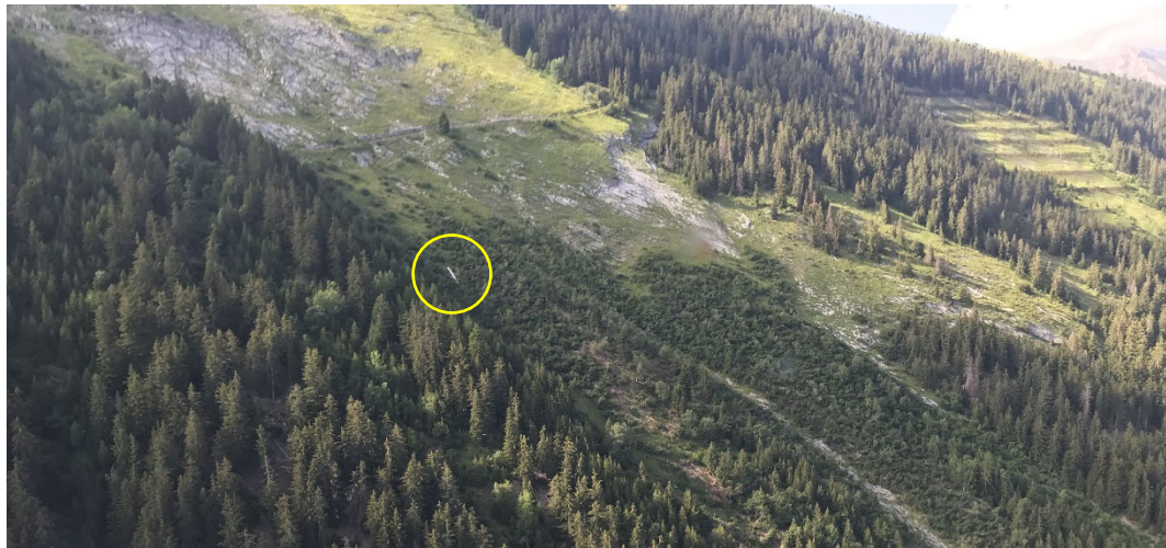
Abbildung 1: Luftaufnahme der Unfallstelle mit nordöstlicher Blickrichtung, aufgenommen am Tag des Unfalls.
