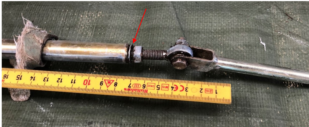
Abbildung 4: Steuerstäbe der Bremsklappen mit loser Kontermutter und Fächerscheibe beim Gelenkkopf (roter Pfeil).
