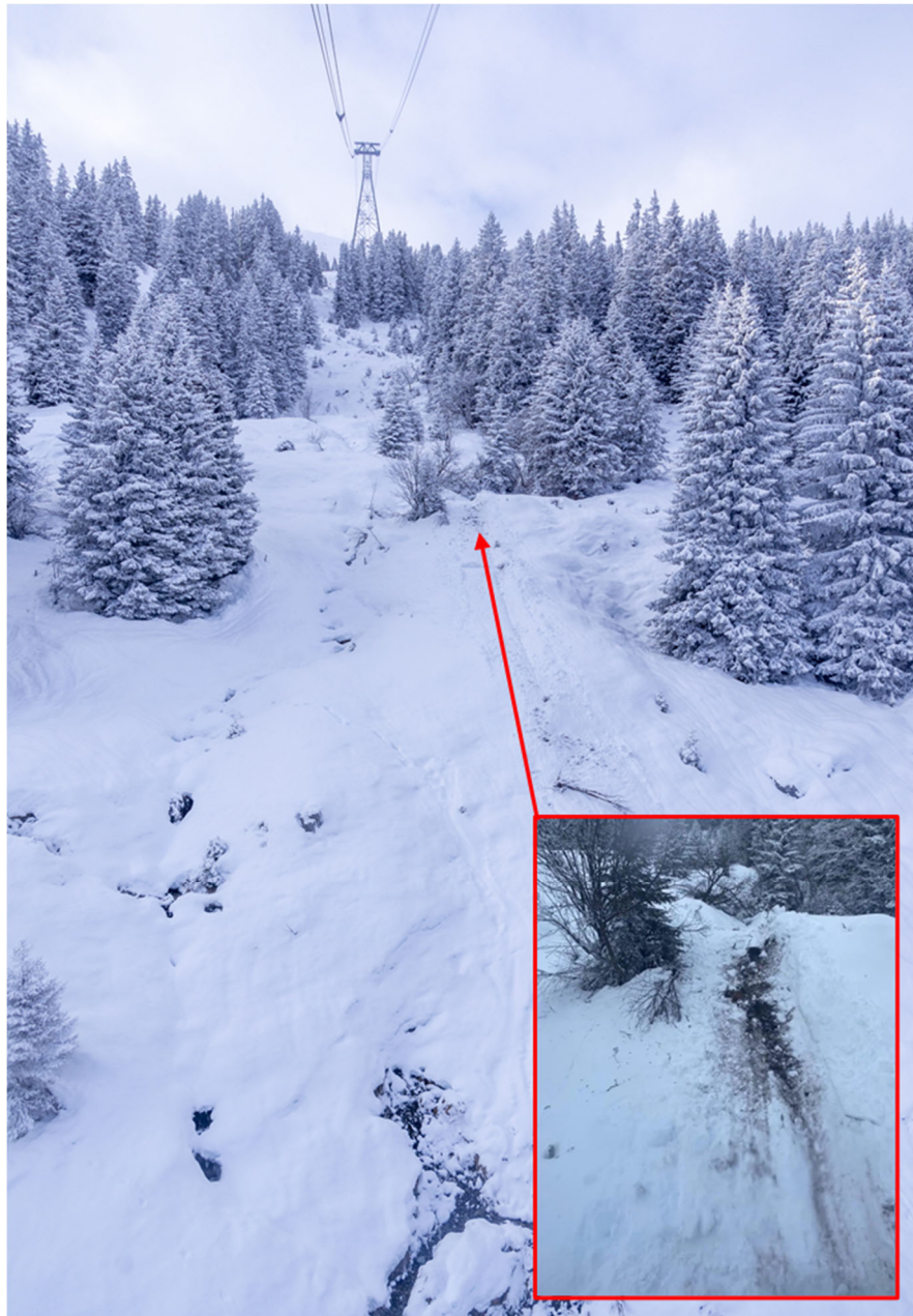
Abbildung 4: Fotografie der Unfallstelle zwischen den Stützen 3 und 4 mit Nahaufnahme der Stelle, an welcher die Lastbarelle mit dem Boden kollidierte. (Quelle: Kantonspolizei GR, bearbeitet durch die SUST).
