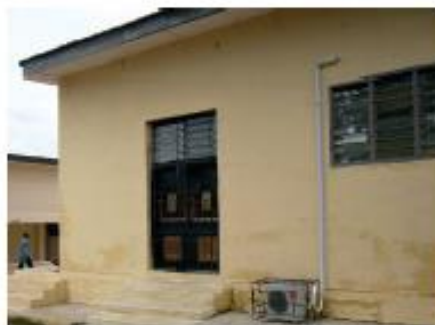
Almacén seguro con ventanas para garantizar una ventilación adecuada, Nigeria
