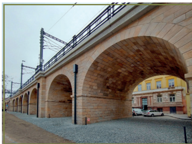
Pískovcové klenby viaduktu po opravách
