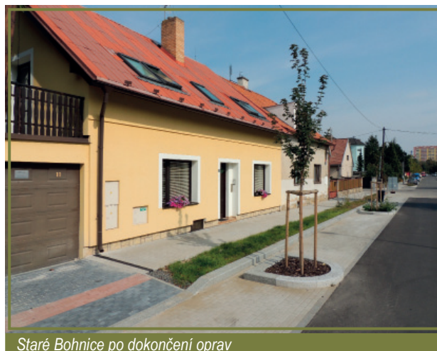
Staré Bohnice po dokončení oprav
