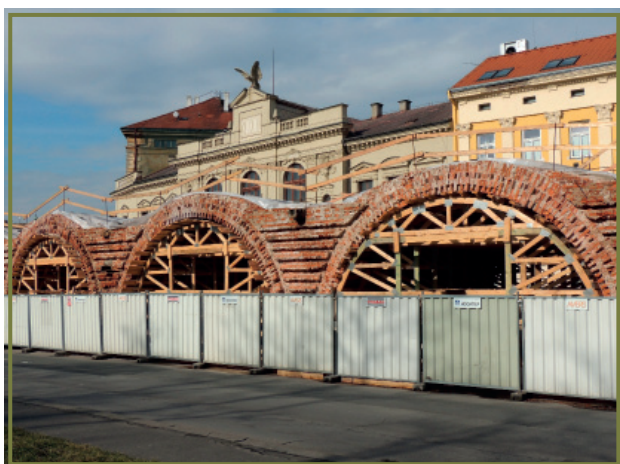
Rekonstrukce Negrelliho viaduktu
