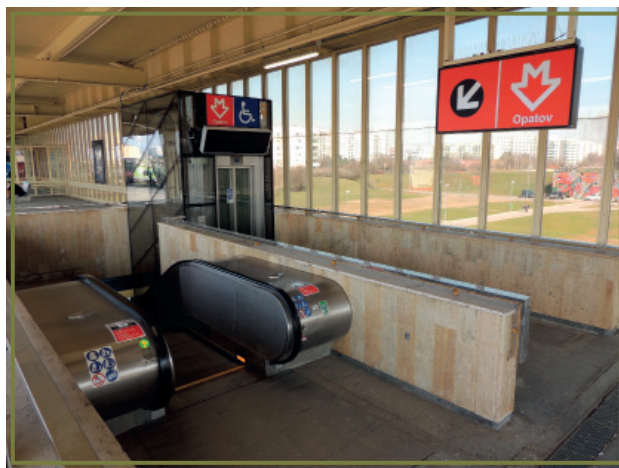
Nový výťah až na autobusové zastávky na Opatově
