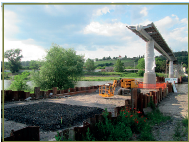
Trojská lávka po usazení středního pole
