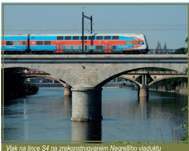
Vlak na lince S4 na zrekonstruovaném Negrelliho viaduktu
