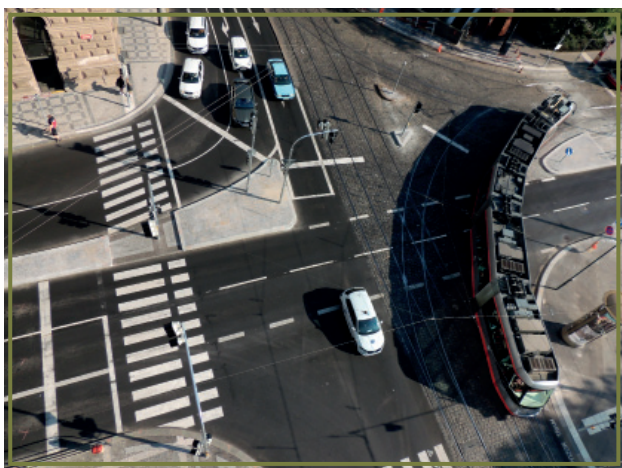
Křižovatka Resslerova – Karlovo náměstí po rekonstrukci
