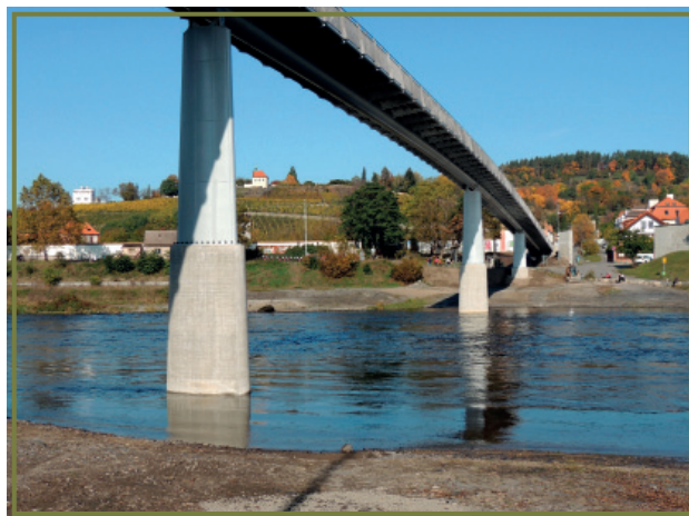
Nová Trojská lávka po dokončení
