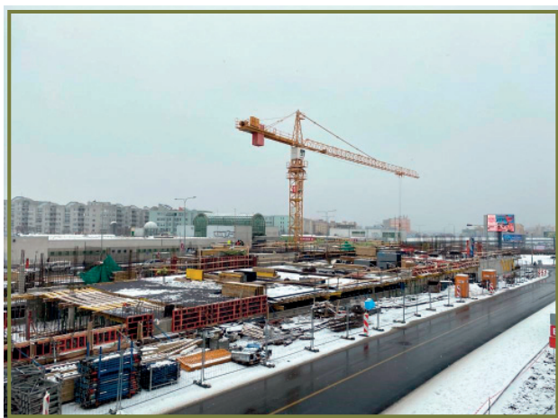
Stavba parkovacího domu P+R Černý Most 1
