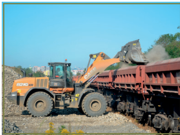
Odvoz zeminy ze staveniště tratě ve Vršovicích v režii ČD Cargo
