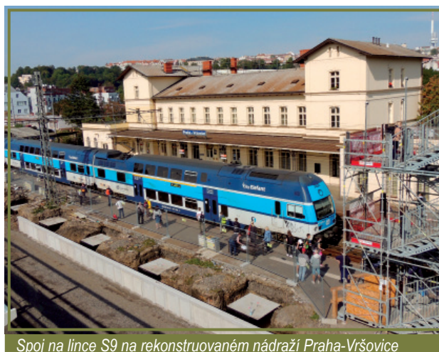
Spoj na lince S9 na zrekonstruovaném nádraží Praha-Vršovice
