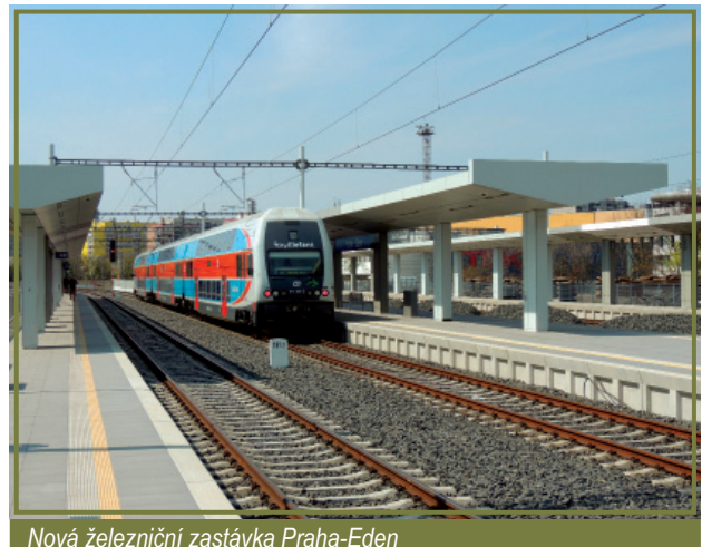
Nová železniční zastávka Praha-Eden
