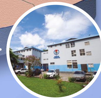
NOVA FRIBURGO Instituto Politécnico (IPRI) Campus Nova Friburgo
