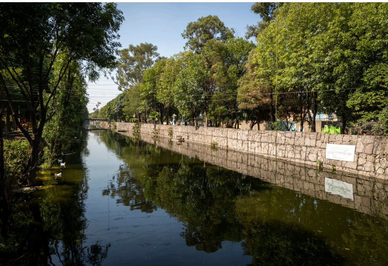
Muro de gavión en el Canal Nacional. Foto: Jaime Navarro
