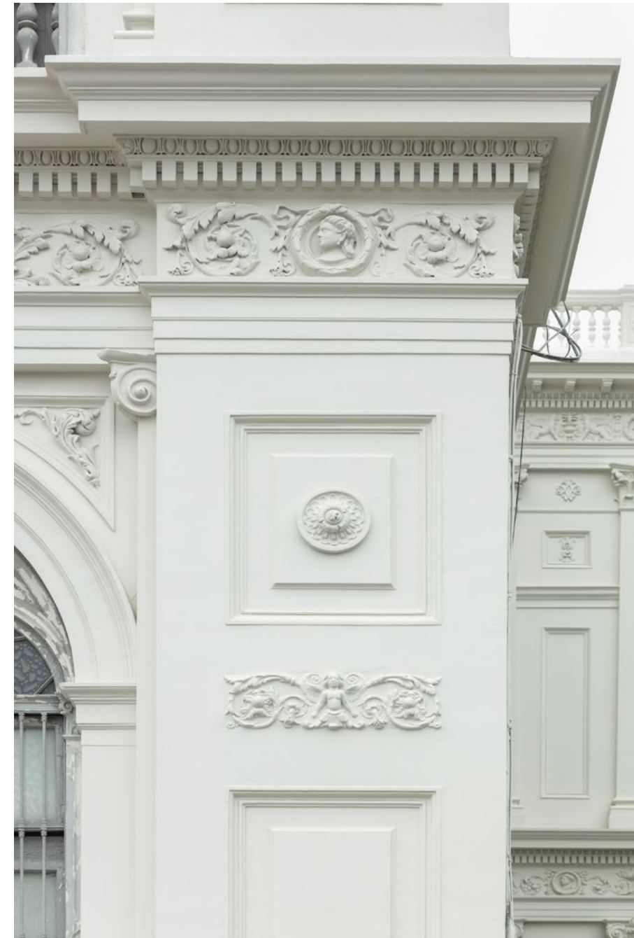
FIG 50 Molduras y ornamentos al final de la restauración, en el nivel superior FOTOGRAFÍA: Archivo WMF Perú
