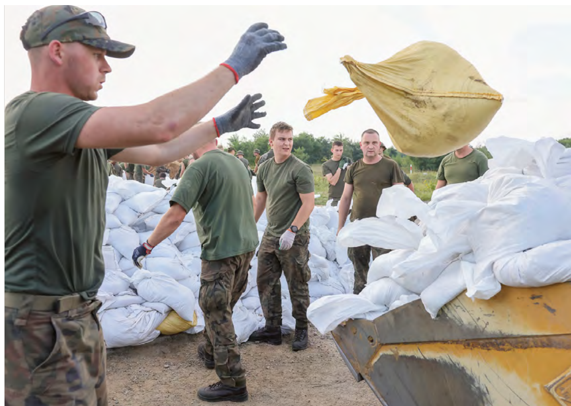
Żołnierze wzmacniają wał obok mostu Brodzkiego, żeby ochronić oczyszczalnię na Janówku przed powodzią
