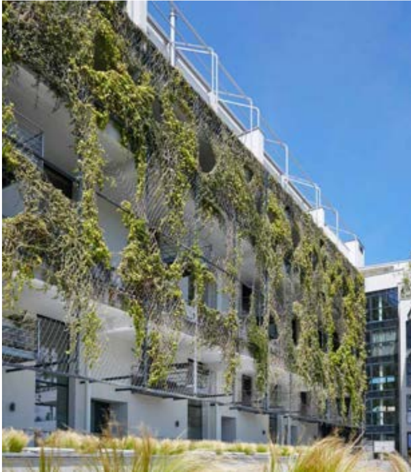
© Jakob AG (Residences en Marens, Nyon, CH)
