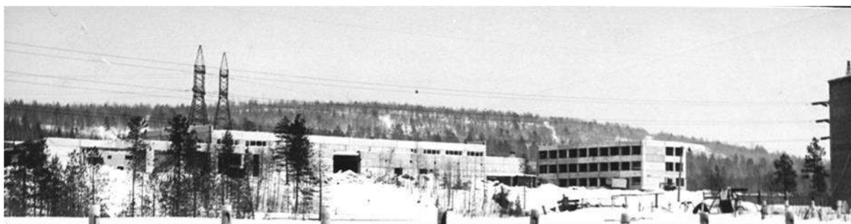
Строительство молокозавода в г. Апатиты. 1982 г. ГОКУ ГАМО в г. Кировске. Ф. Р-520. Оп. 1. Д. 3363.
