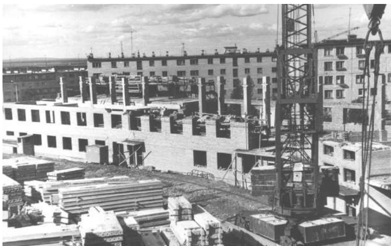
Строительство родильного дома на 60 коек в г. Апатиты. 1976 г. ГОКУ ГАМО в г. Кировске. Ф. Р-520. Оп. 1. Д. 2497.
