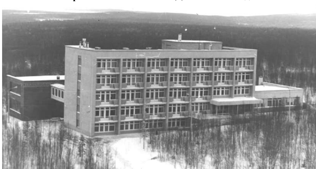
Санаторий-профилакторий треста «Апатитстрой». 1978 г. ГОКУ ГАМО в г. Кировске. Ф. Р-520. Оп. 1. Д. 2561.
