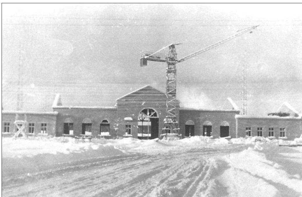
Новый город. Строительство вокзала. 1960 г. ГОКУ ГАМО в г. Кировске. Ф. Р-42. Оп. 6. Д. 363.
