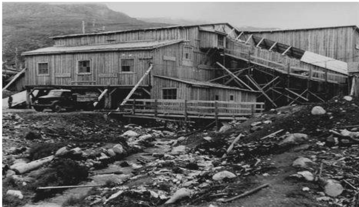
Бетонный завод. 1951 г. ГОКУ ГАМО в г. Кировске. Ф. Р-179. Оп. 12. Д. 499.
