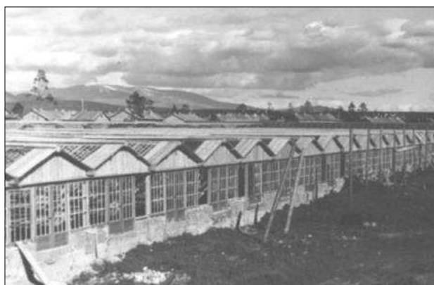
Новые теплицы в совхозе «Индустрия» ГОКУ ГАМО в г. Кировске. Ф. Р-179. Оп. 12. Д. 787.
