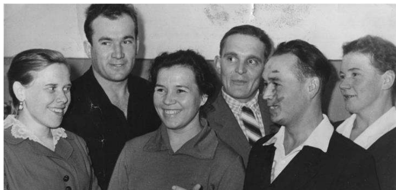
Группа строителей Кировской ГРЭС. 1962 г. ГОКУ ГАМО в г. Кировске. Ф. Р-19. Оп. 3. Д. 380.
