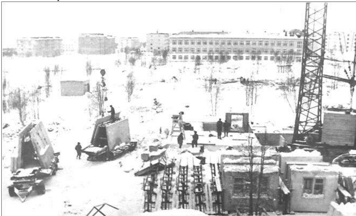
Крупноблочное домостроение. Новый город. 1963 г. ГОКУ ГАМО в г. Кировске. Ф. Р-42. Оп. 6. Д. 489.
