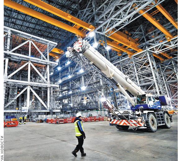
В Белокаменке Мурманской области монтируют металлоконструкции для крупнотоннажных морских сооружений.
