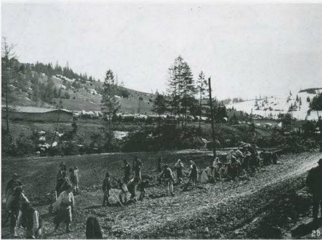
Ремонт дороги в с. Опорець
