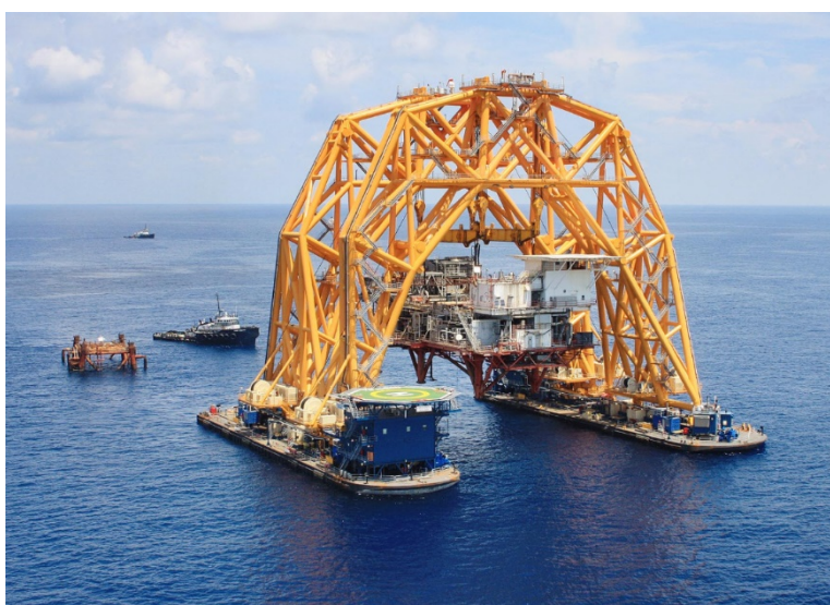
Figur 8-11 Versabar HLV 10.000 t topside installering på jacket.
