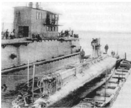
Пл, погруженная на баржу для дальнейшей транспортировки
