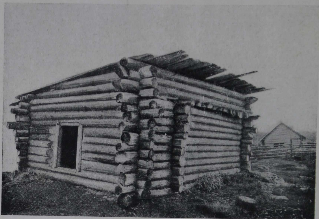
220. Баня. Деревня Пельдожи Сямозерского района
