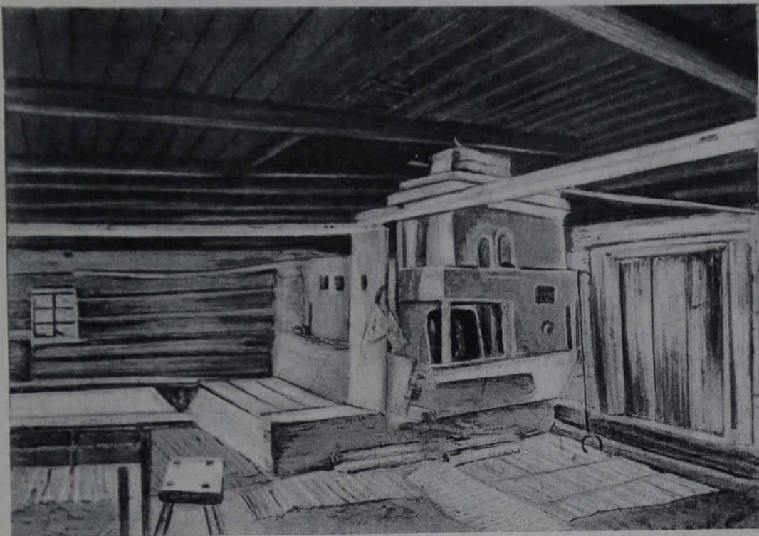
43. Внутренний вид избы с белой печью, только что переделанной из черной. Деревня Угмойла Сямозерского района
