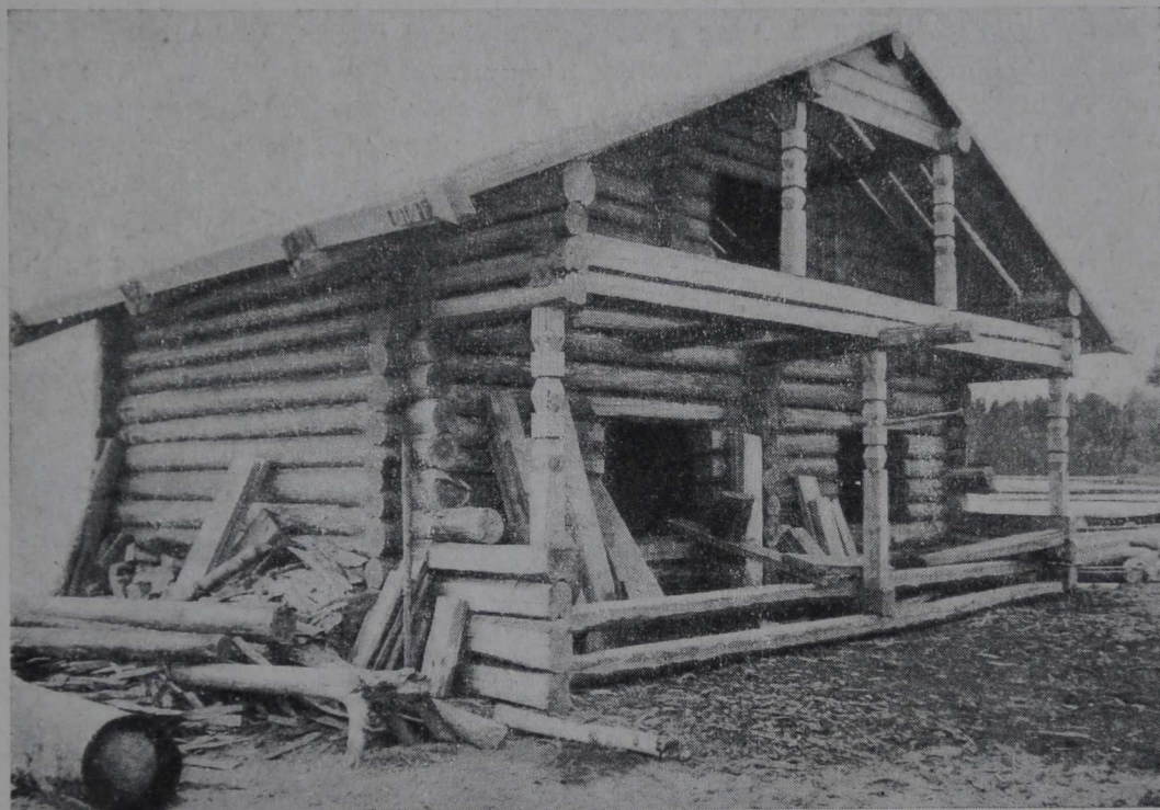
215. Вновь построенный амбар. Деревня Алекки Сямозерского района
