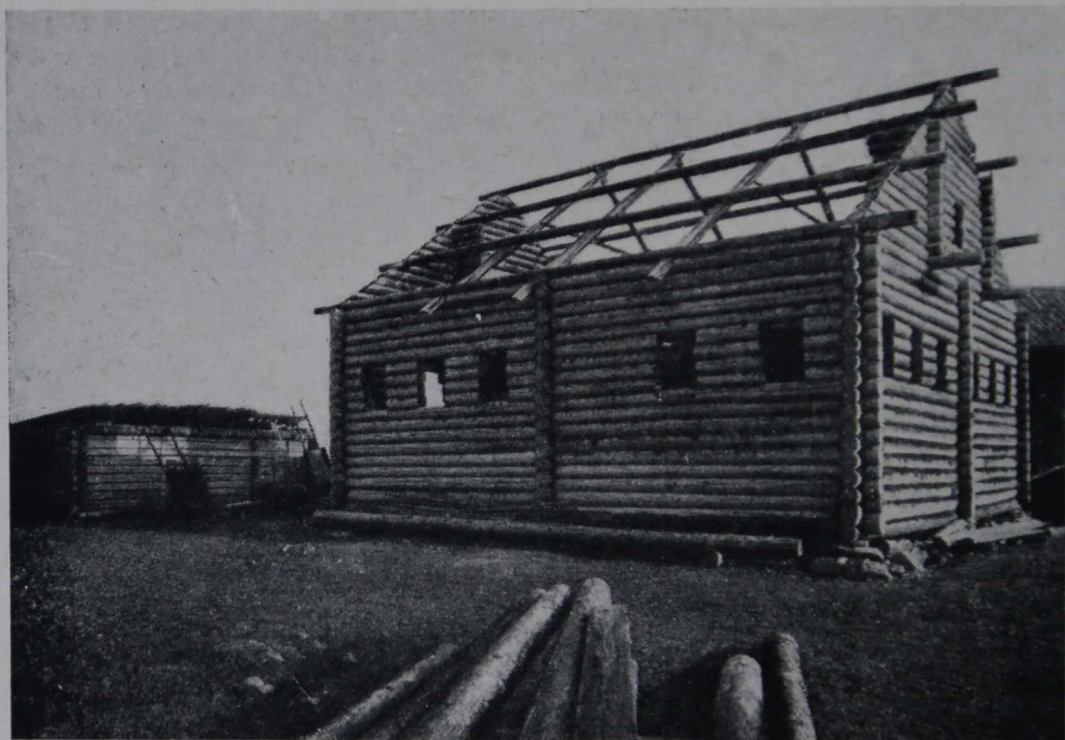
64. Строящийся дом. Связи бревенчатого фронтона. Село Святнаволок Петровского района
