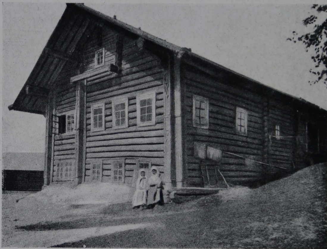
206. Обшивка торцов бревен. Деревня Заостровье Олонецкого района
