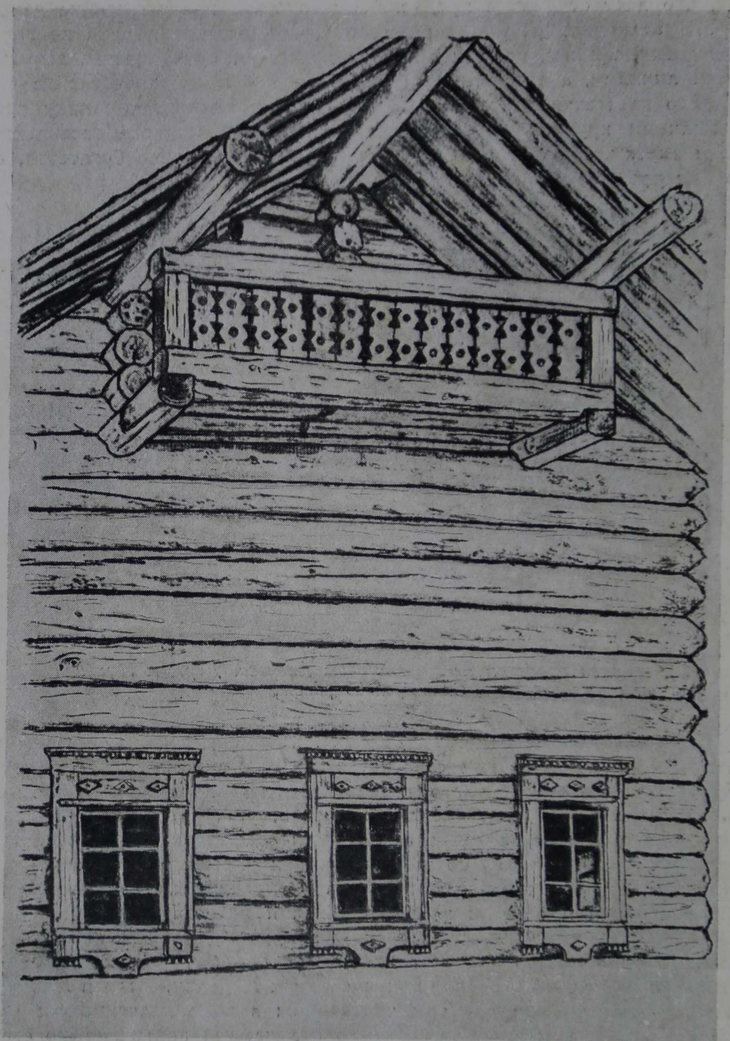
130. Детали старого дома. Село Сямозеро Сямозерского района
