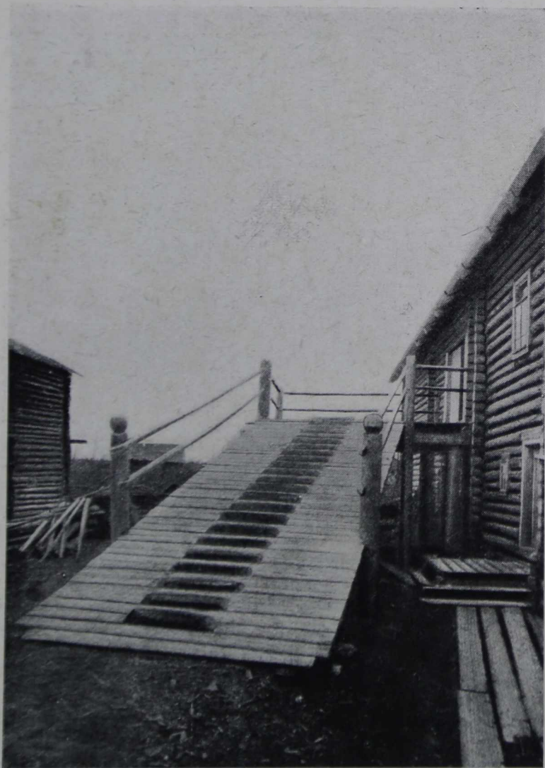
194. Новый взвоз у дома. Деревня Котчила Олонецкого района
