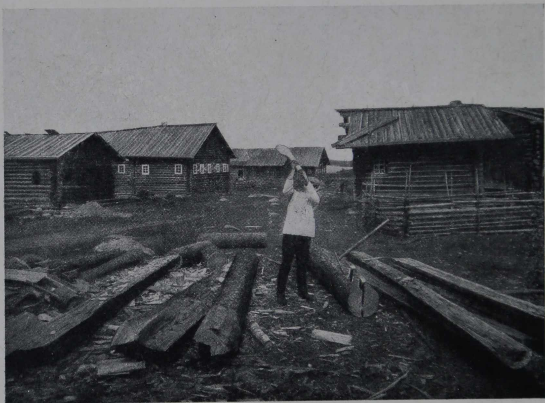
60. Изготовление теса топором. Деревня Юстозеро Медвежегорского района
