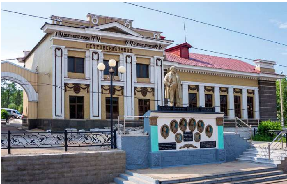
Железнодорожная станция Петровский Завод
