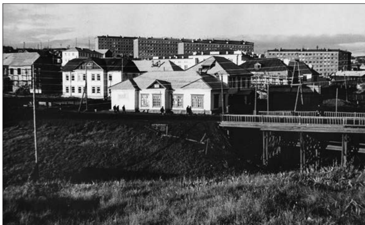
С 1935 года по этому старому деревянному мосту проходили на работу и с работы заключенные. Тогда здесь не было этих домов: госбанка, здания УЖКХ с сантехническим участком и многоэтажных домов...
