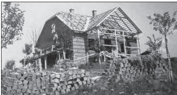
Výstavba hostovského domu
