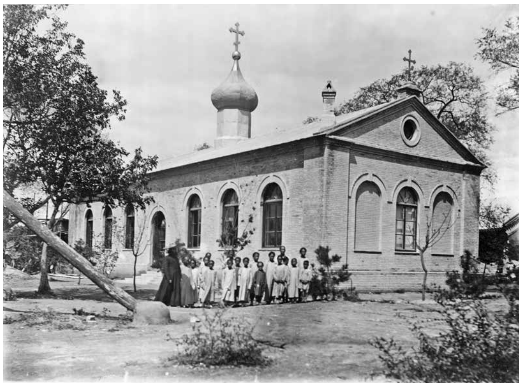
Вид Успенской церкви с юго-восточной стороны
