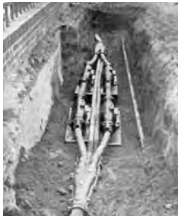
Verlegung von Pupinspulen für Erdkabel
