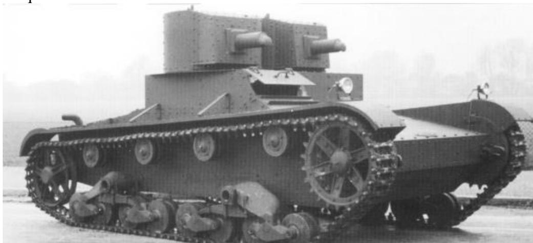
*Tanque Vickers Mark E Type A (armado con dos torretas con ametralladoras)*
