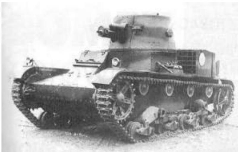
*Tanque Vickers Mk E Type B con cañón de 47 mm y ametralladora coaxial*
