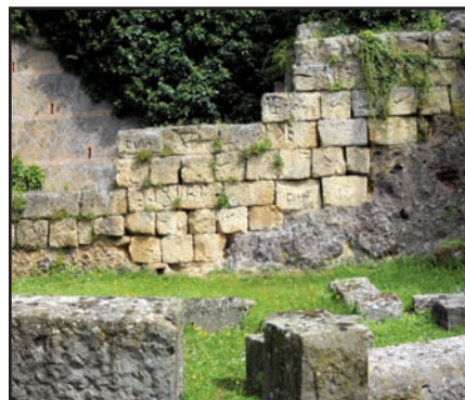
Upper wall section Via Orvietana.
