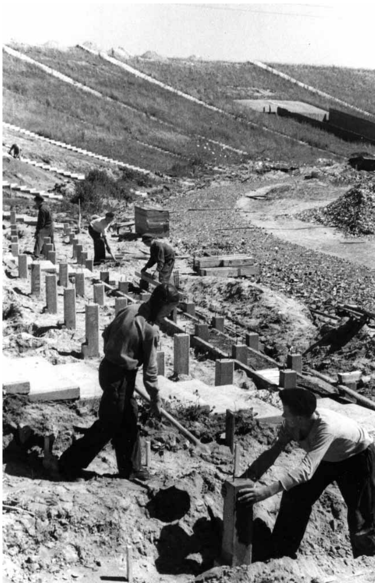
Строительство стадиона. На снимке: плотники М. Орлов (слева), А. Медведев устанавливают железобетонные тумбы. Фотохроника ЛенТАСС, июнь 1948
