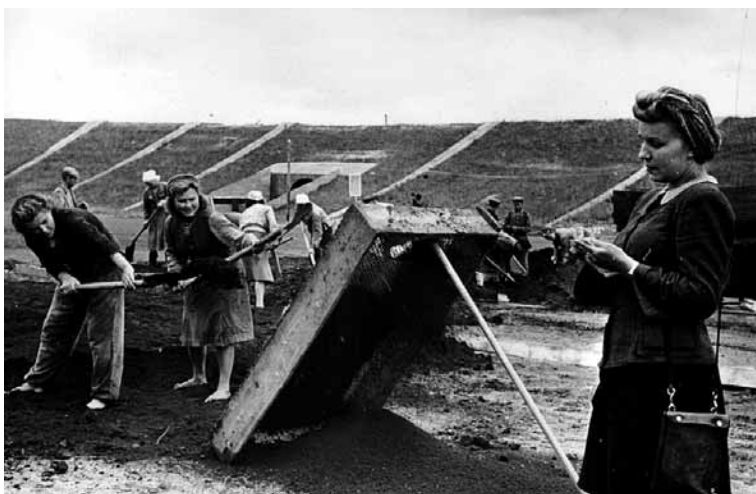
Строительство стадиона. Бригада Л. И. Кошкиной готовит футбольное поле стадиона. Фотохроника ЛентАСС, июнь 1948
