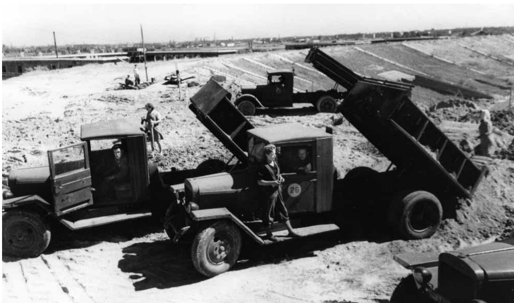
Строительство стадиона. Самосвалы сгружают землю с вершины холма. Фотохроника ЛентАСС, июнь 1948
