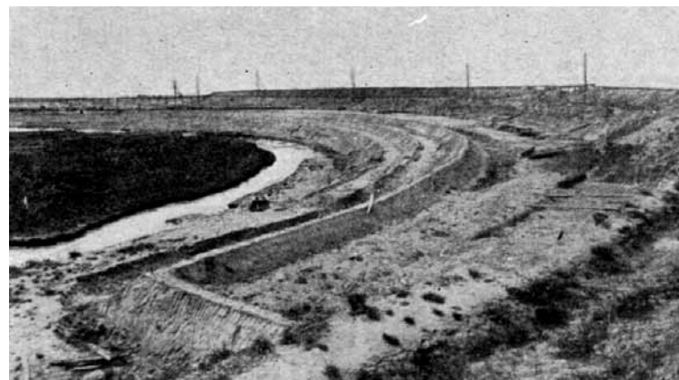
Земляные работы на стройке стадиона. Фото 1930-х
