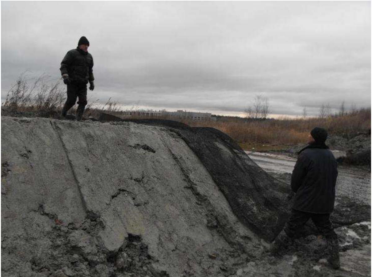
Рис. 8.2.1. Укладка георешетки при капитальном ремонте дамбы обвалования карты-котлована №64.
