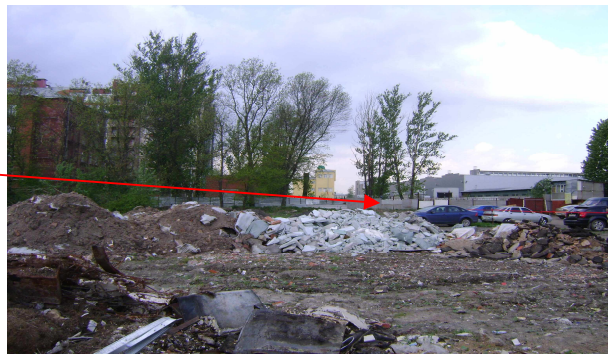
Рис. 9.3.2. Та же территория, вид с земли пр. Обуховской обороны, д.105
