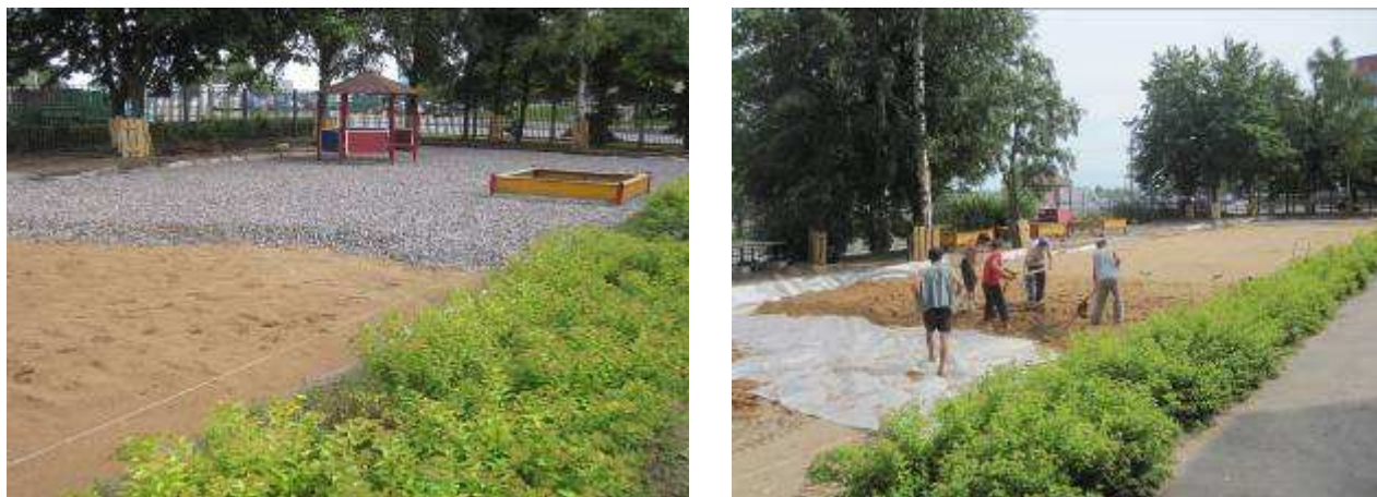
Рис. 3.3. Этап обратной засыпки чистых материалов
