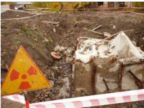
Рис. 3.9. Деактивация участка радиоактивного загрязнения (слева) и работы по разборке старых строительных конструкций (справа).
