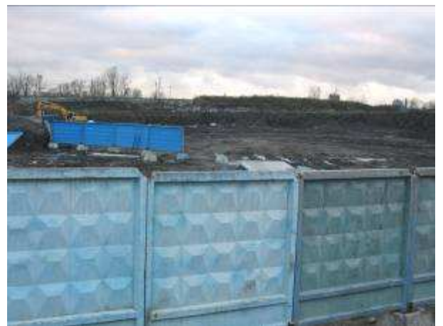
Рис. 3.8. Ведутся работы по вывозу свалочных масс (слева) и установке бетонного ограждения (справа).
