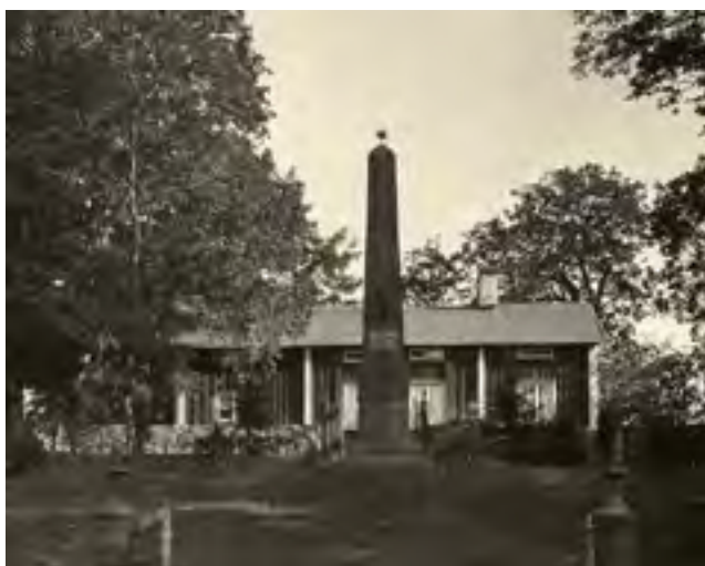
Foto från 1922 som visar sätesstugan från väster före restaureringen på 1930-talet. Källa: Smålands museum, fotograf K Kjellmark.
