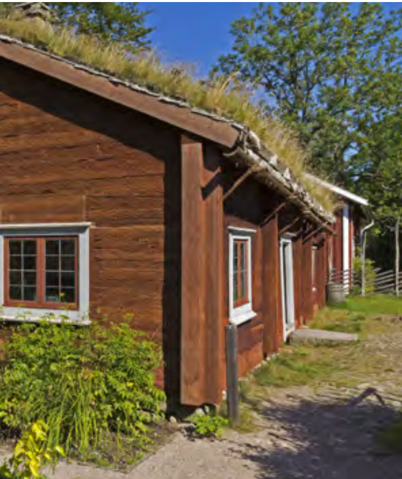
Den rekonstruerade lustgården vid sätesslugans södra gavel. Trädgården anlades ursprungligen av komminister Nils Linnæus. På gavelns vägg ser man märkena som under åren 1832-1843 bar upp fasadens puts. Man kan också tydligt se hur fönstren återställts till sin ursprungliga form då huset restaurerades på 1930-talet. Foto: Pierre Rosberg, Kalmar läns museum.
