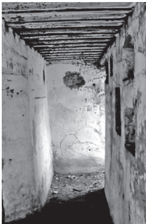
Силовая станция. Оформление входа в виде сквозника. Фото С.В. Киреева.
