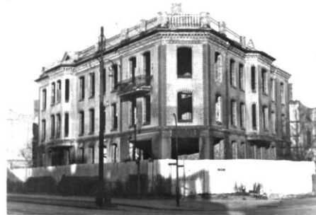
5. Здание, трудно поддающееся реконструкции / Детали выполнены из облицовочного кирпича /
