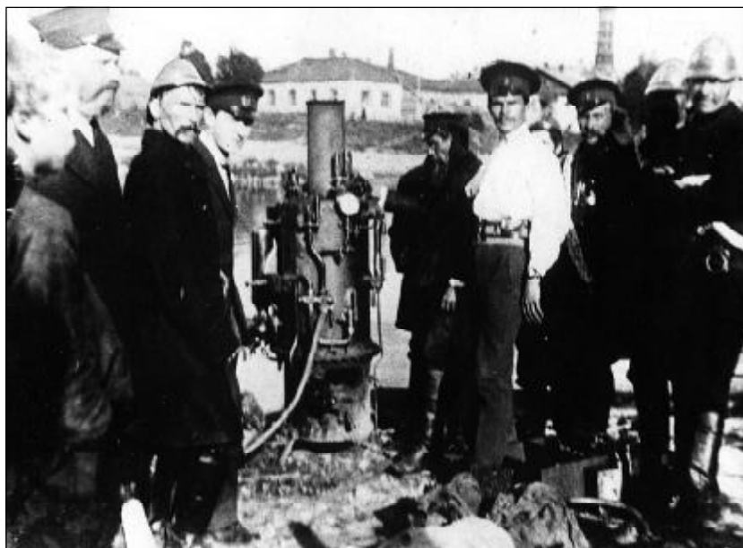
Испытания пожарной паровой машины на берегу р. Шелони
