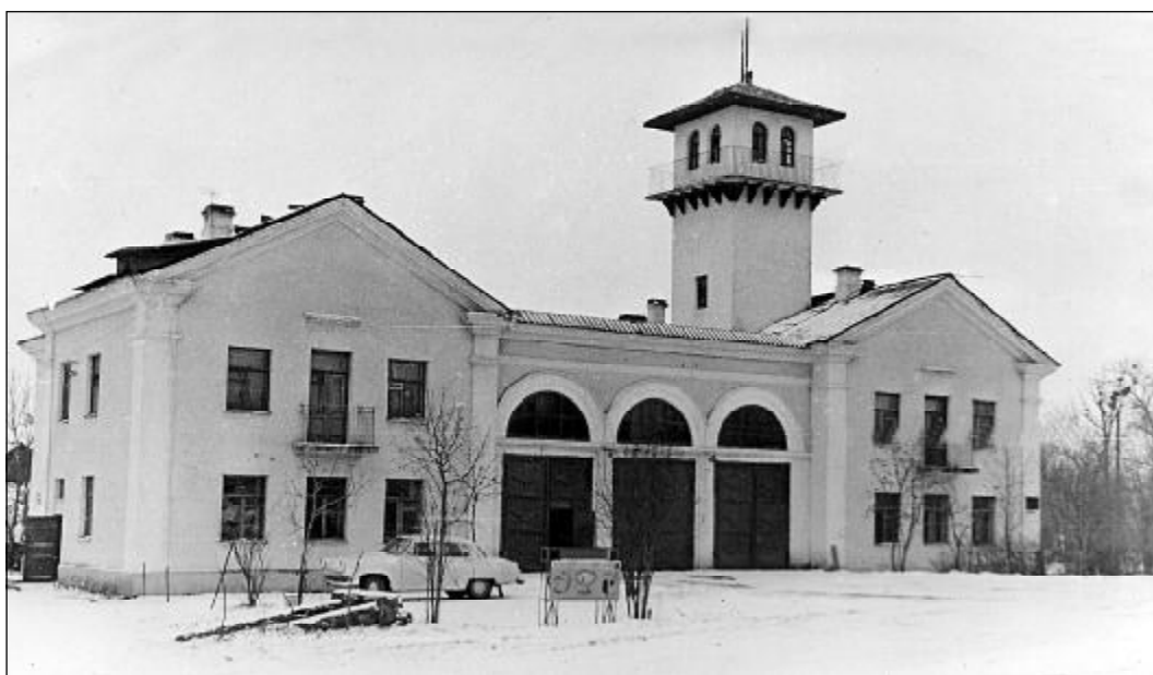
Современное здание пожарного депо. 1979 г.
