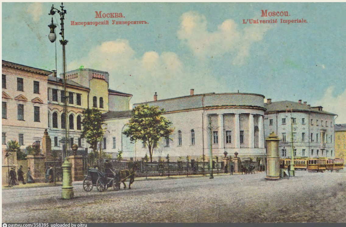
Перестроенное здание Аудиторного корпуса. 1904 г.
