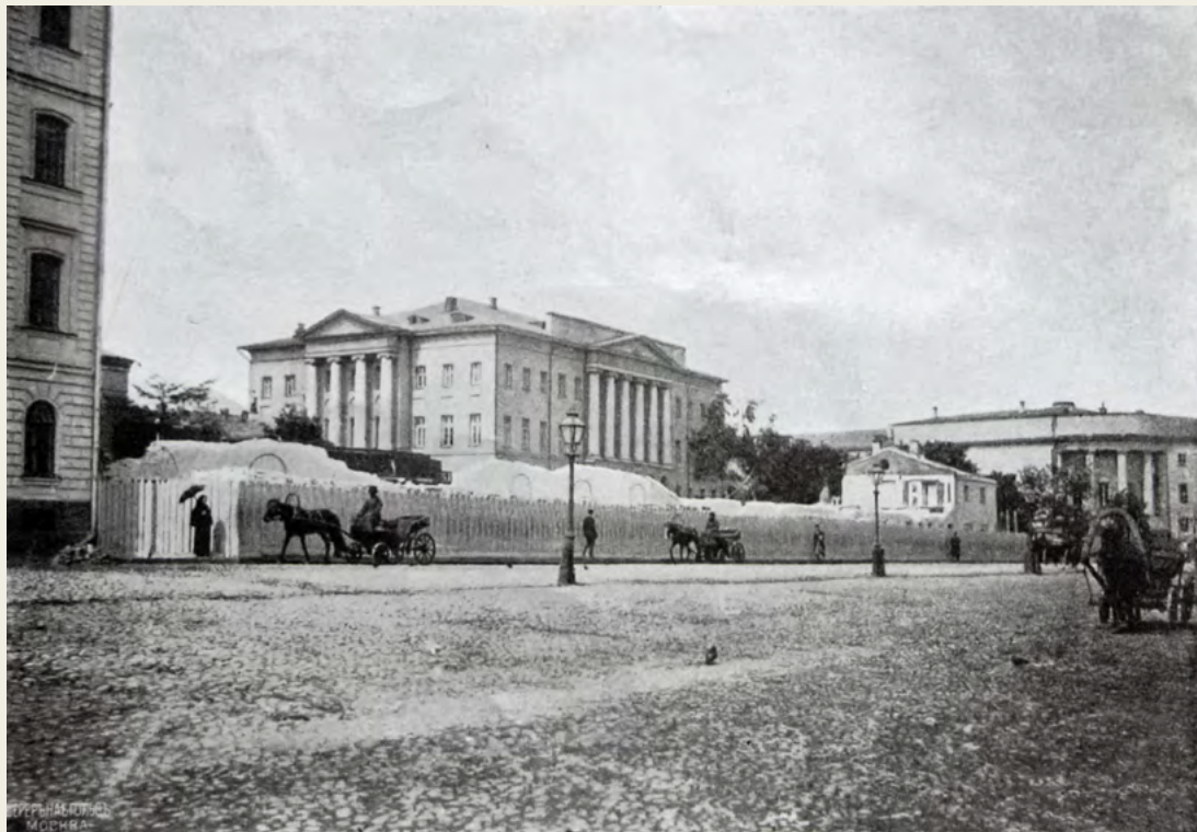
Начало строительства университетской библиотеки. 1897 г.
