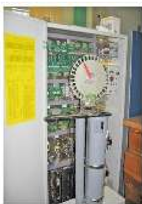
Стенд для проверки плат управления лифтом ШК-5903 для проверки и ремонта плат лифта. фото 5.
