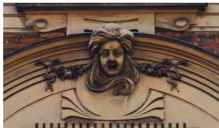
Vodnik House, 1902, Ljubljana. Detail of the façade Casa Vodnik, 1902, Ljubljana. Detall de la façana
