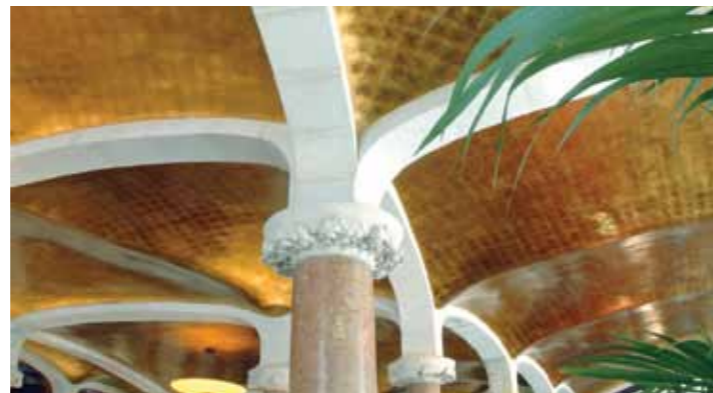
Ceiling of the Café Vienès on the ground floor of the Hotel Casa Fuster Sostre del Café Vienès a l'interior de l'Hotel Casa Fuster, antic saló de celebracions
