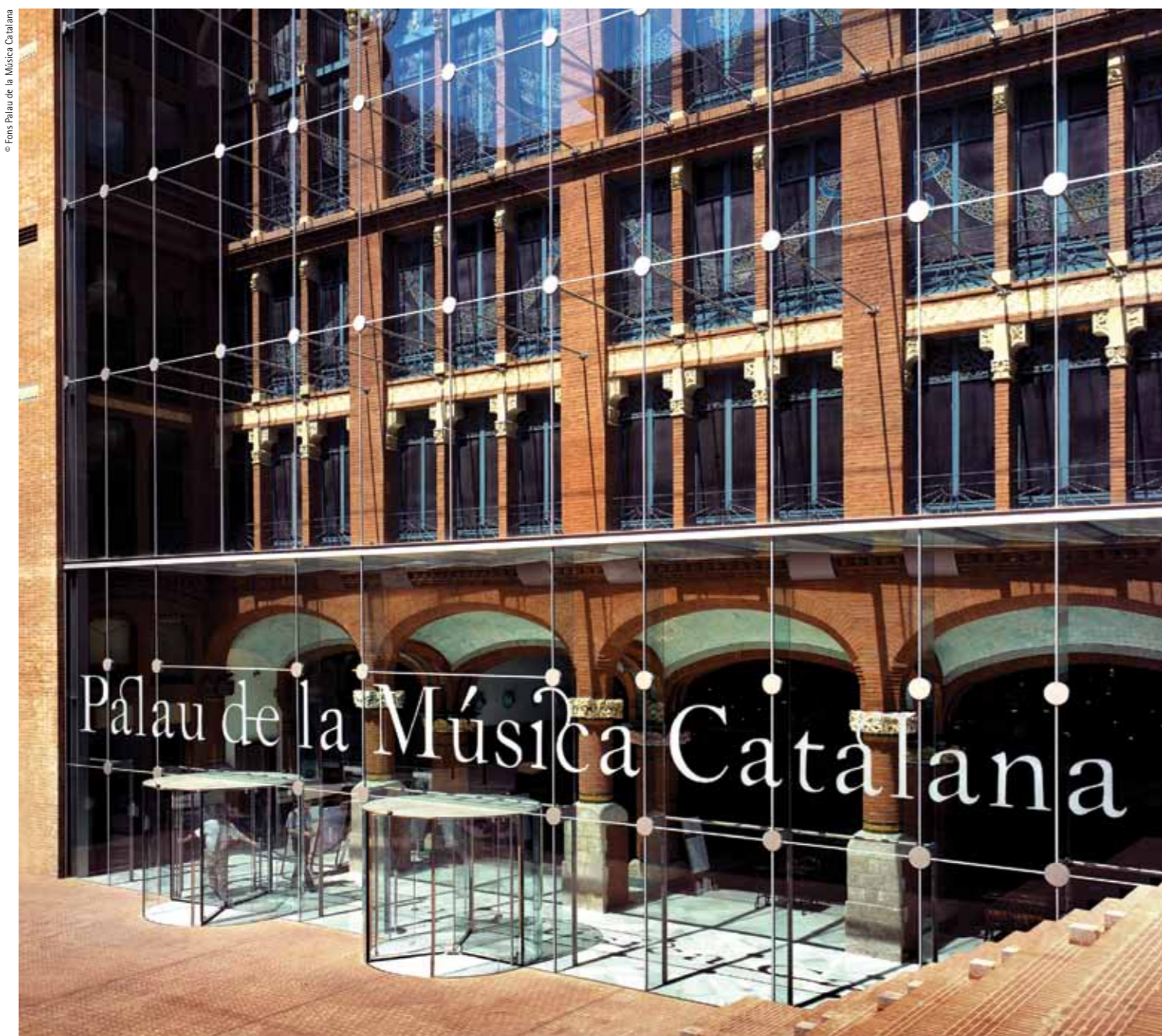
This façade was revealed during extension work in 2004 / Façana que va quedar al descobert l'any 2004 amb les obres d'ampliació
