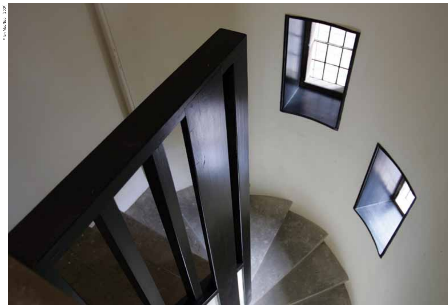
South West Stairwell / Escala de la banda sud-oest
