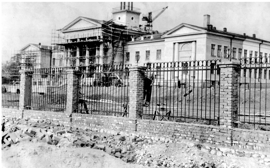
Строительство Дворца пионеров
